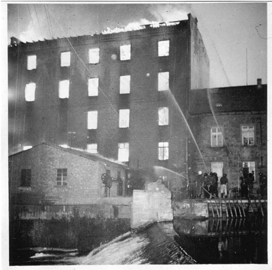
Löscharbeiten auf der Rückseite
