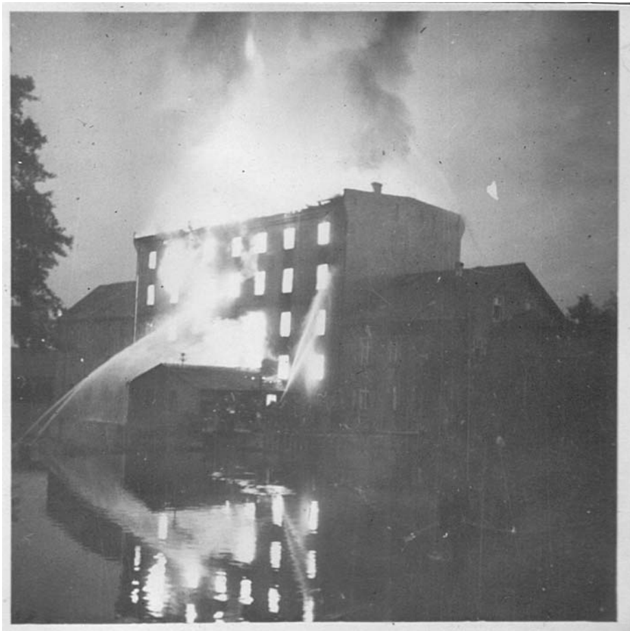
Löscharbeiten auf der Rückseite
