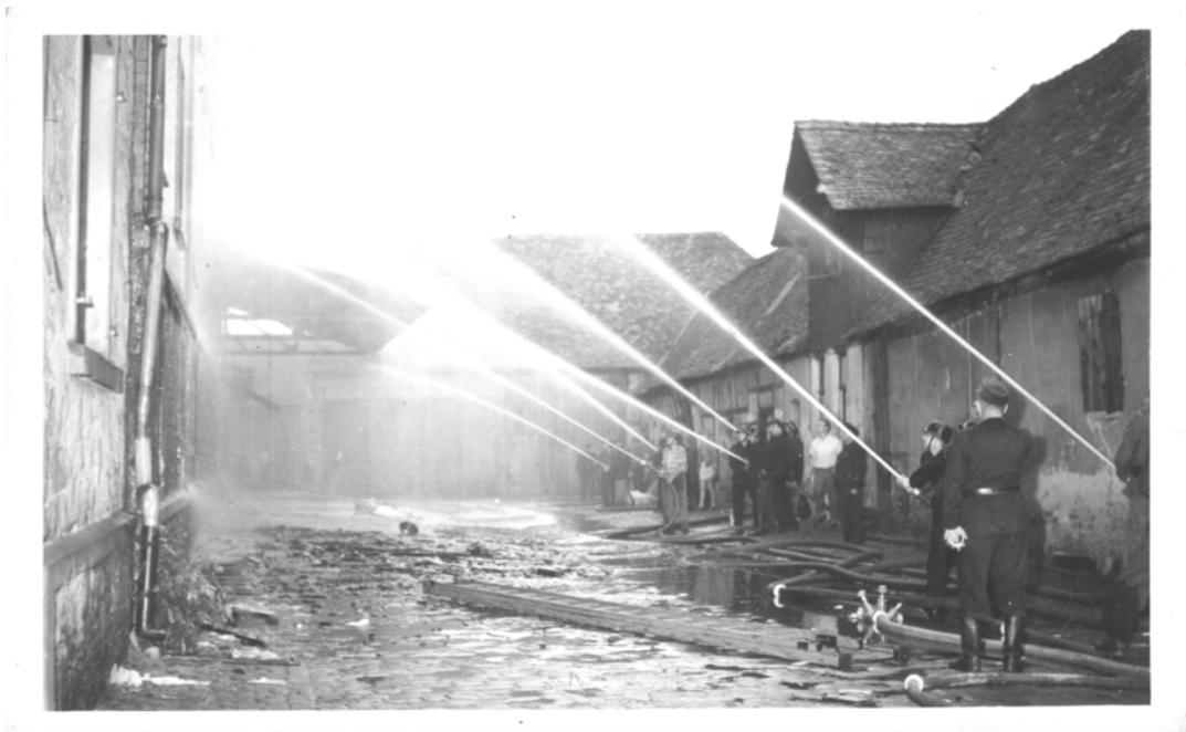
Löscharbeiten im Innenhof
