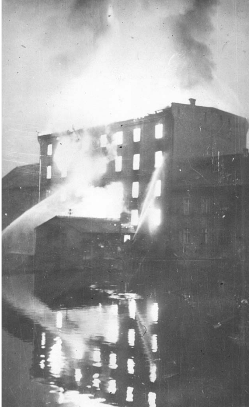
Löscharbeiten auf der Rückseite
