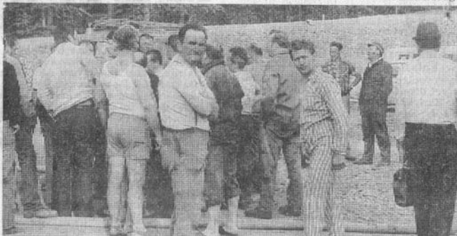
Sogenannter Zählappell gegen 6 Uhr: Teils in Schlafanzügen oder anderer Nachtbekleidung hatten sich die Bauarbeiter ins Freie geflüchtet.
