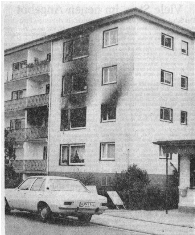
Erheblich beschädigt wurden drei Wohnungen bei dem Brand in der Kastellstraße 4 in Rückingen, wo heute nacht eine Amerikanerin ums Leben kam. Foto: Greiner
