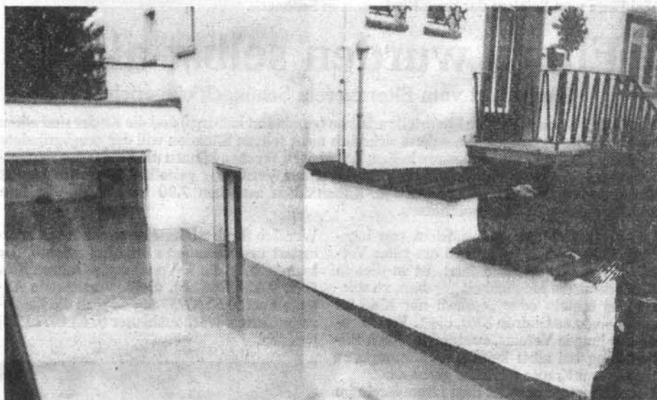
Ein typisches Bild: Die Grundaflut ist in eine tiefliegende Garage eingedrungen und natürlich auch wieder in die Kellerräume.
