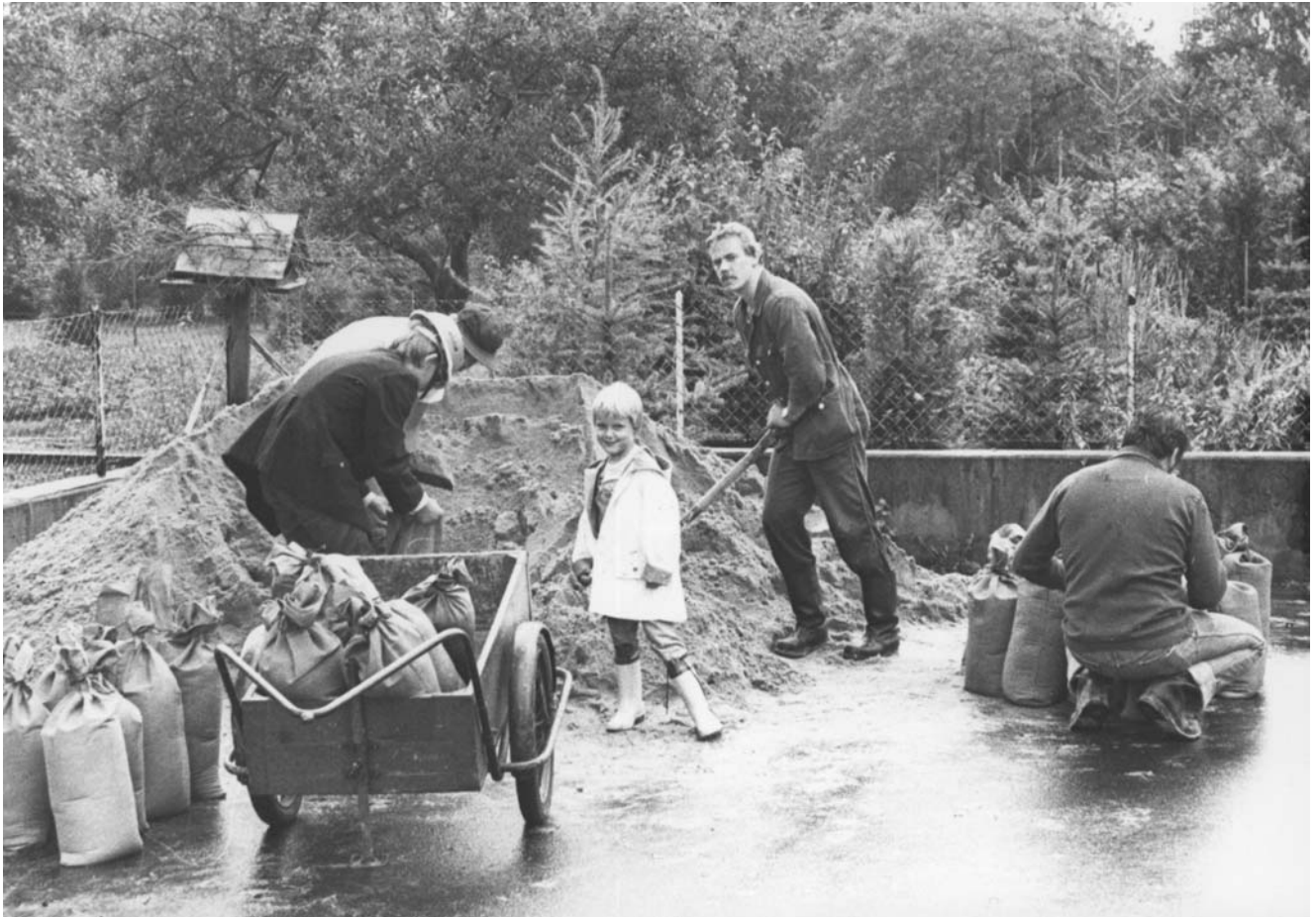
Sandsäcke füllen Gerätehaus Rückingen An der Wasserburg
