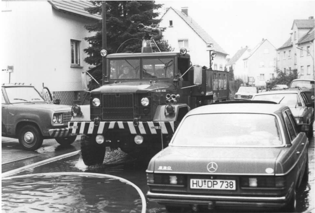
US Feuerwehr in der Landwehrstraße
