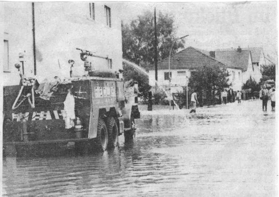
Auch die Flugplatzfeuerwehr der Amerikaner war ständig bemüht, den Wasserpegel in den Häusern niedrig zu halten.
