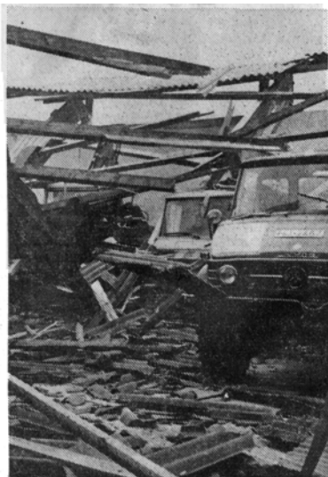
Auch der Bauhof der Stadt Bruchköbel wurde durch die Explosion erheblich in Mitleidschaft gezogen. Das Gebälk ist über den Fahrzeugen zusammengestürzt.
