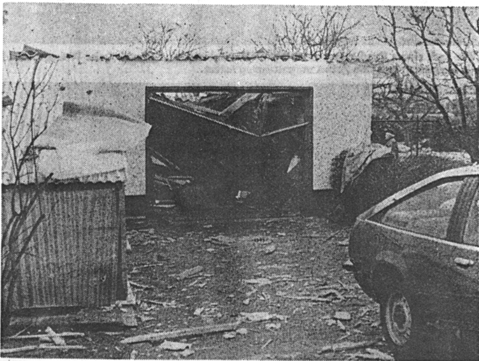
Diese eingestürzte Garage ist kein Einzelfall. Eingedrückte und aus den Angeln gehobene Tore und Fenster sowie von Dachziegeln, Balken und Glassplittern übersäht Gärten und Grundstücke prägen am Dienstag das Bild in den Straßen um den Unglücksort.
