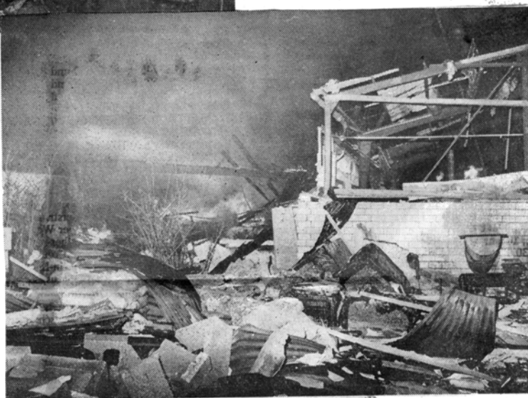
Zwischen den Trümmern der eingestürzten Halle detonierten ständig herumliegende Sprayflaschen.
