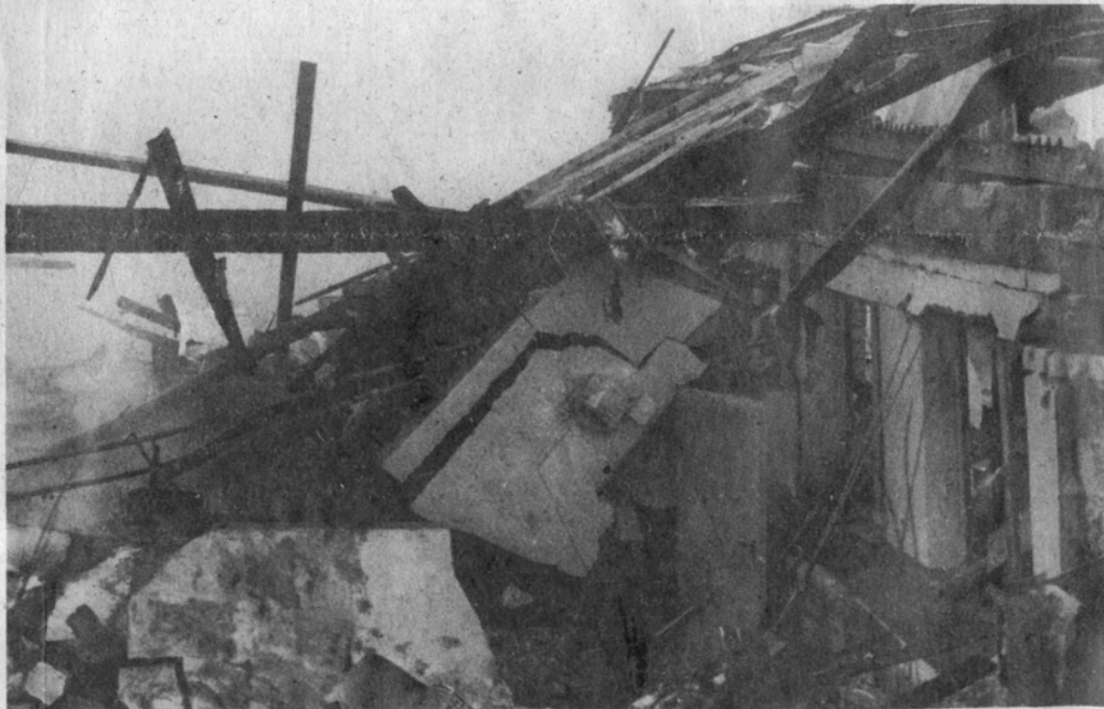
Auf dem Firmengelände der Kosmetikfirma Reinelt blieb kein Stein mehr auf dem anderen.
