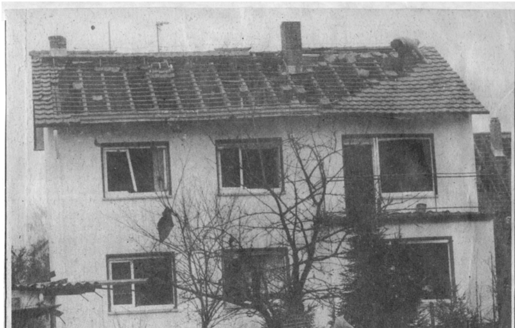
Eines der total demolierten Häuser, die direkt an der Hammersbacher Straße „stehen“.
