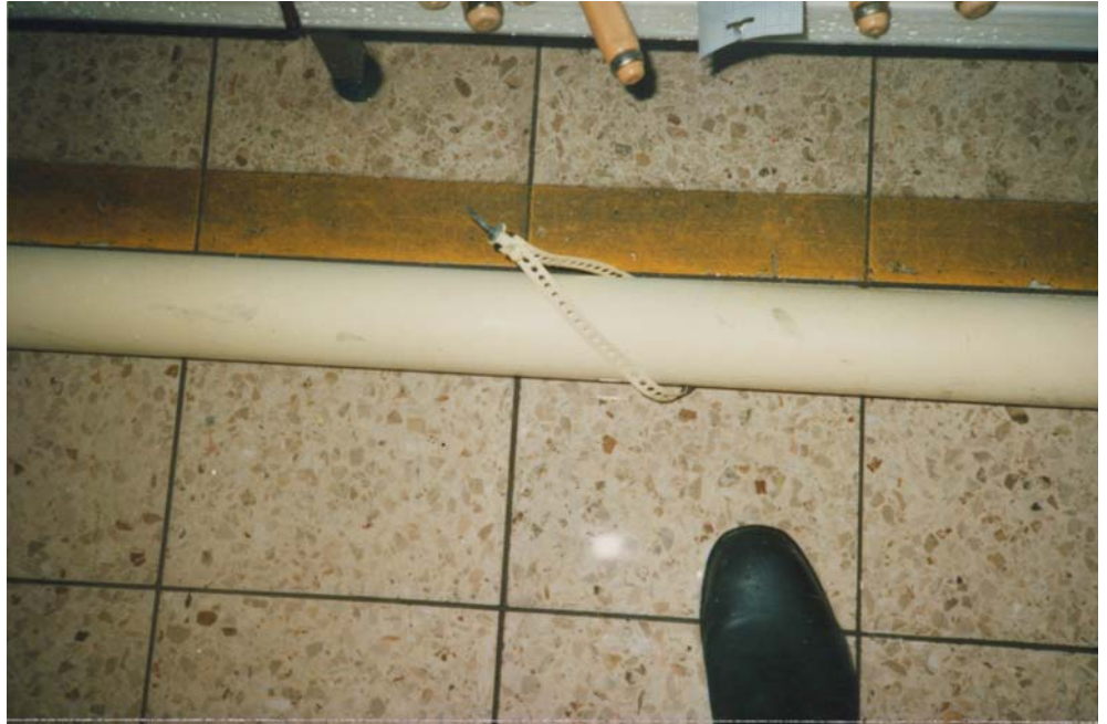
Die abgerissene Leitung der Sprinkleranlage
