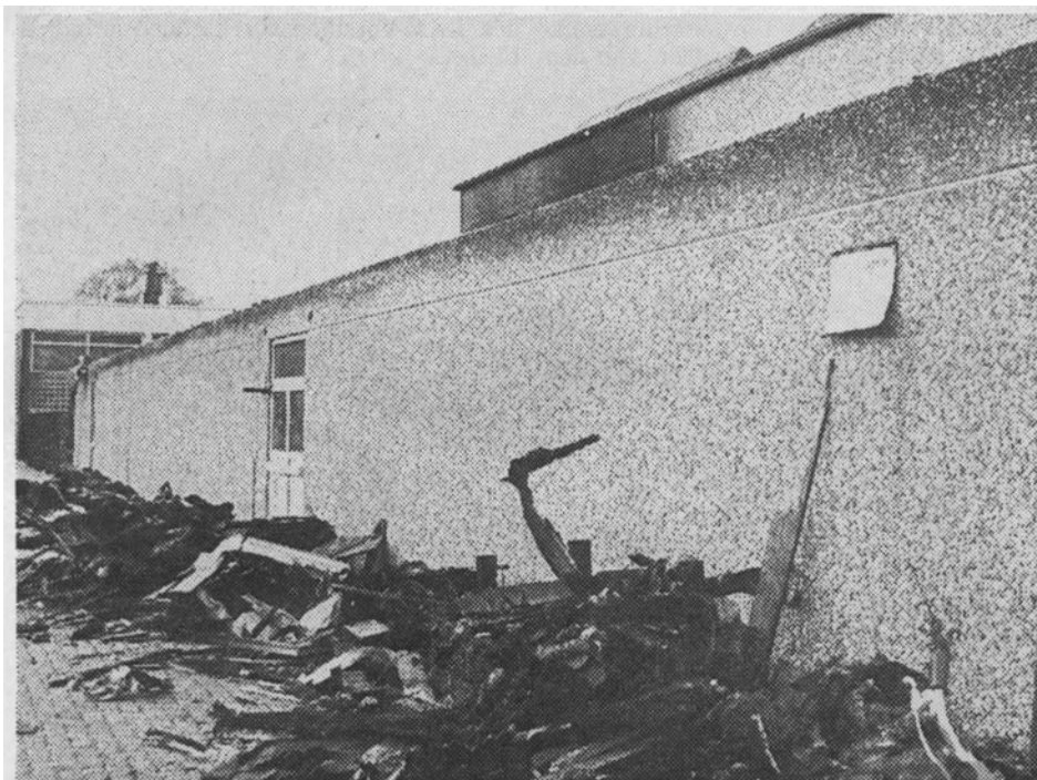
Das Dach des Seitentraktes der Sporthalle wurde völlig zerstört. Ob die sonstige Bausubstanz gelitten hat, muß noch von Experten geprüft werden.
