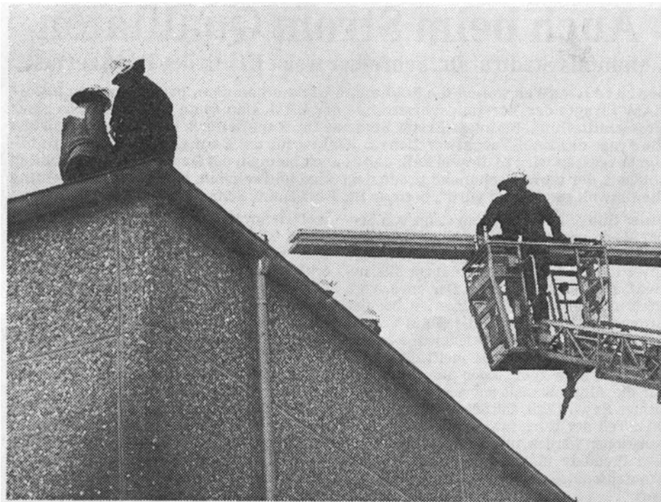
Die eingeschlagenen Glasdächer wurden noch am Abend von der Feuerwehr mit Balken von großen Zeltplanen abgedeckt.
