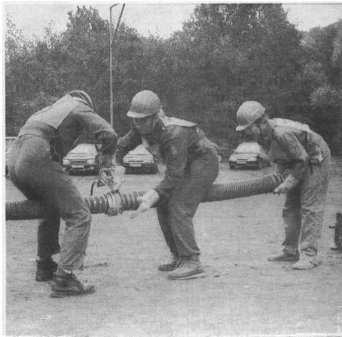
In kürzester Zeit mußten die Prüflinge eine Leitung legen. (Fotos: Ziegert)
