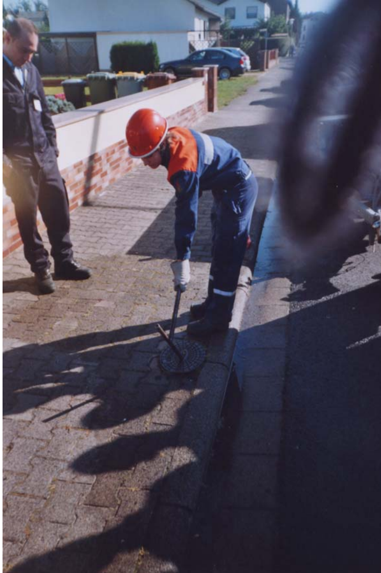
Standrohr setzen
