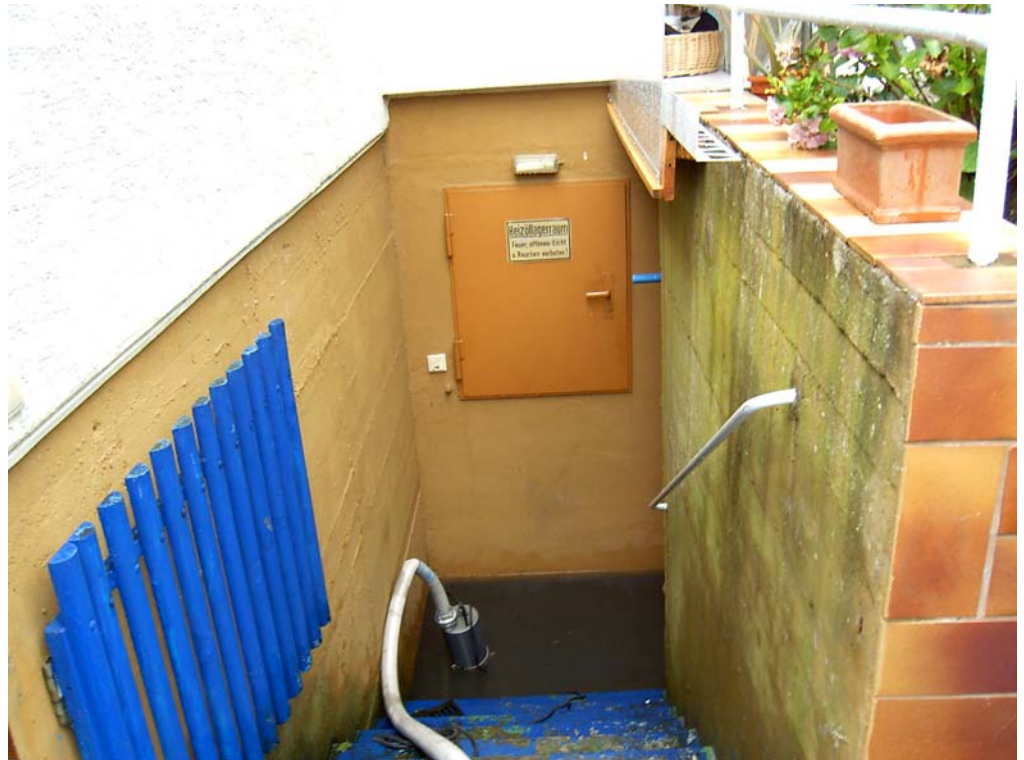
Einsatzstelle: An der Kläranlage
