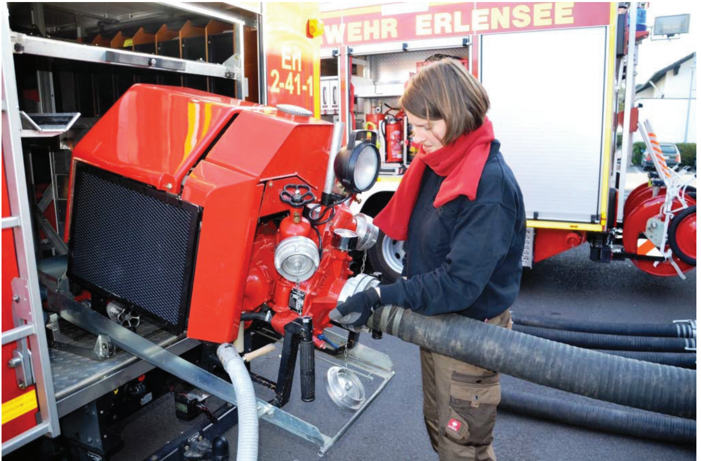
Prüfung der Ansaugschläuche und der Pumpe
