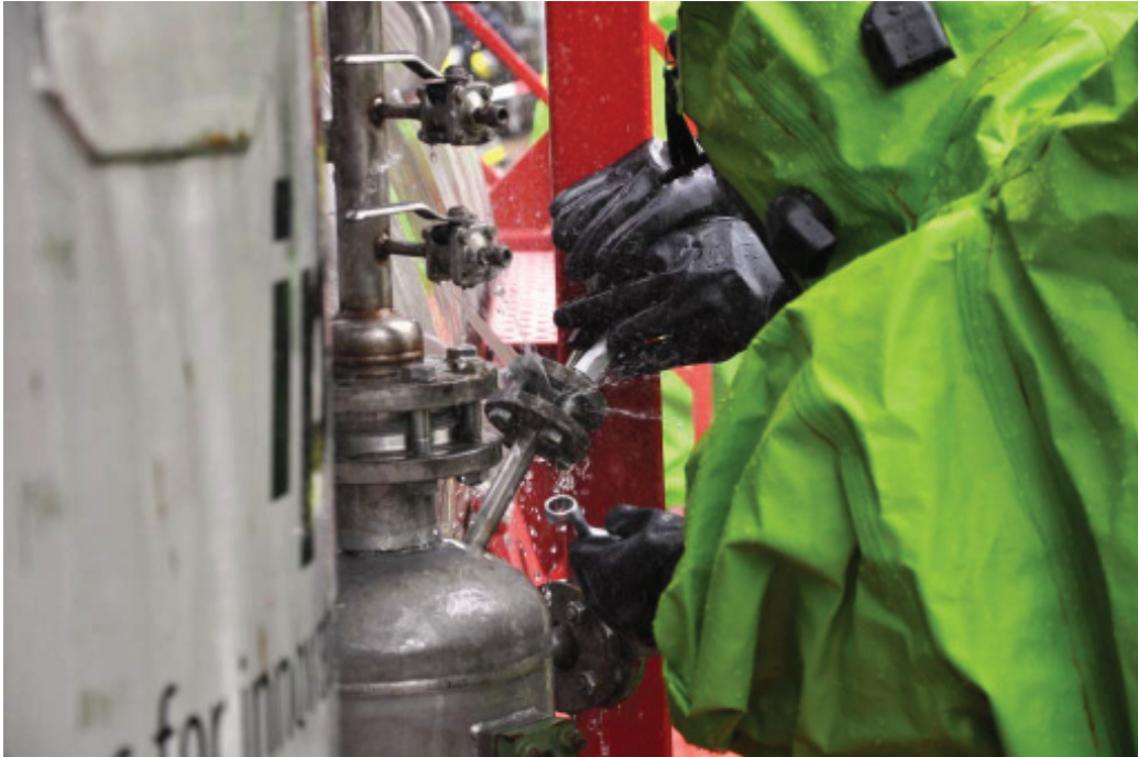
Anziehen und Abdichten des Flansches
