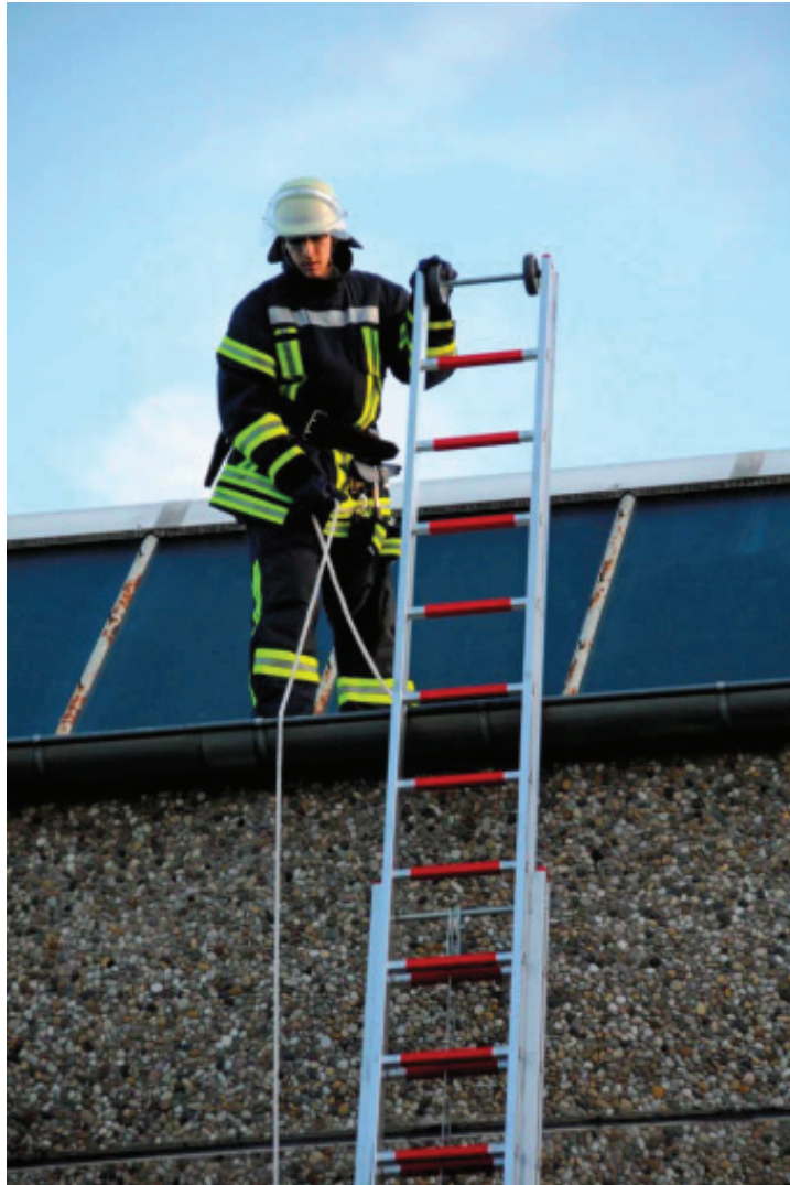
Mit einem Seil wurden Werkzeug und Hilfsmittel auf das Dach befördert
