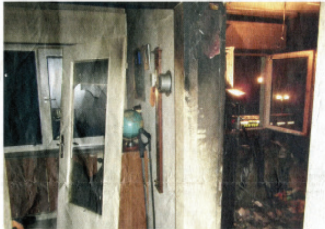
Die Wohnung wurde aufgrund des Feuers und der starken Hitzeentwicklung zerstört. Fotos: Privat/Bender (2)
