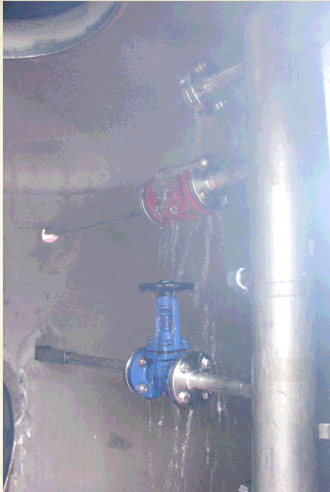
Undichter Flansch, aus dem der Gefahrstoff austritt
