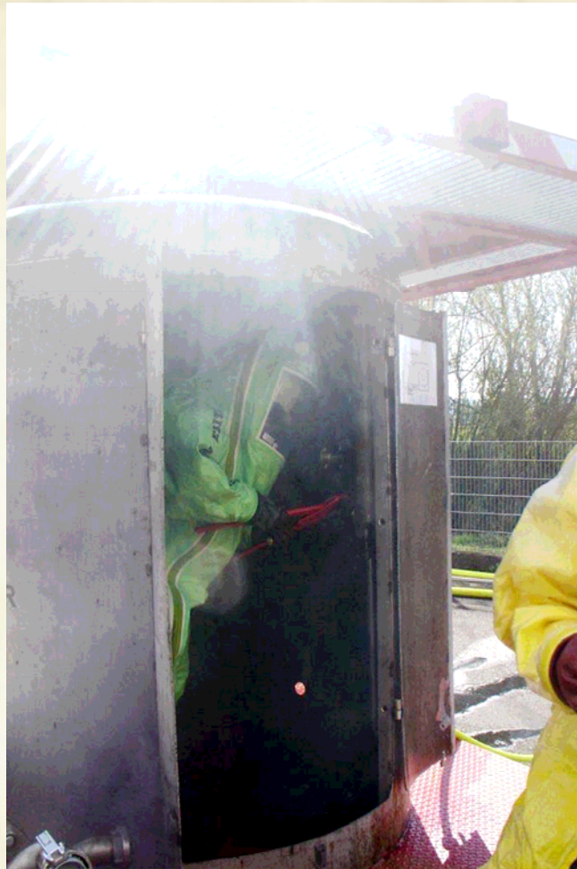
Abdichten einer undichten Rohrverbindung
