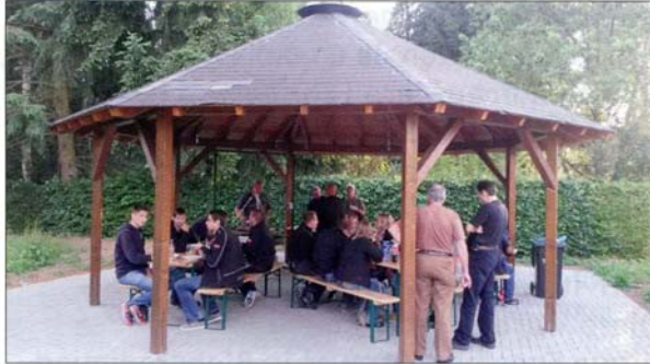
Durch ehrenamtliche Arbeit und Sponsoring kam die FFW Rückingen zu einer Grillhütte
