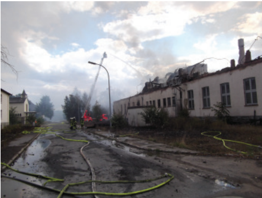
Löscharbeiten auf der Gebäude-Rückseite (Abschnitt 3)
