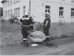
The "Technische Hilfswerk" build the lighting for night
