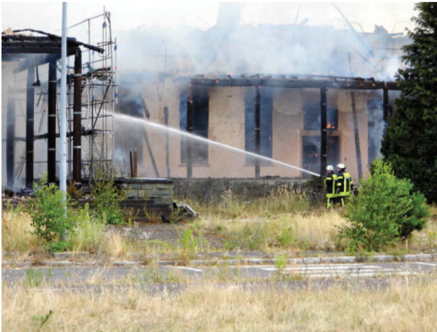
Löscharbeiten auf der Vorderseite des Gebäudes
