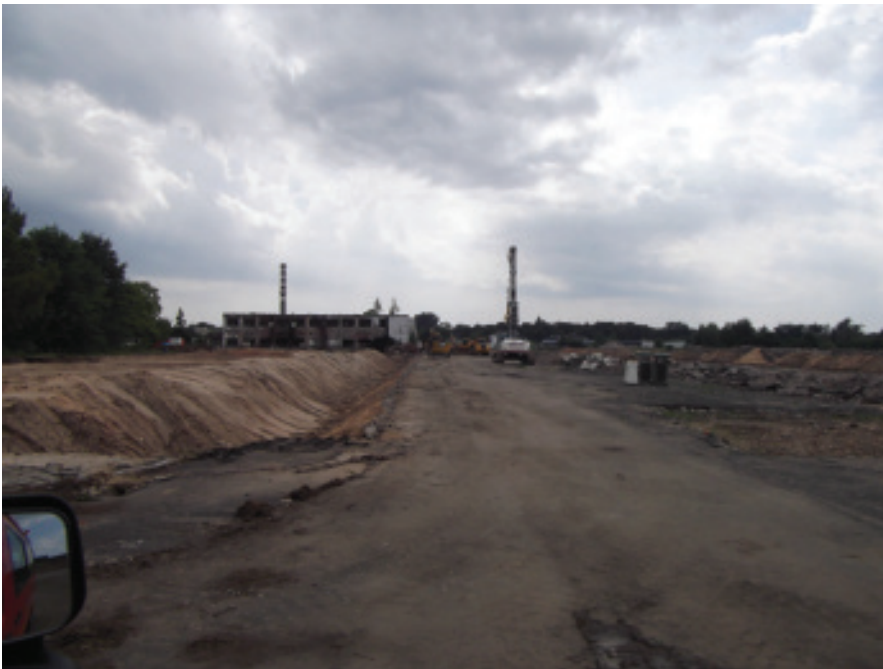
Die Baustelle im Jahr 2014
