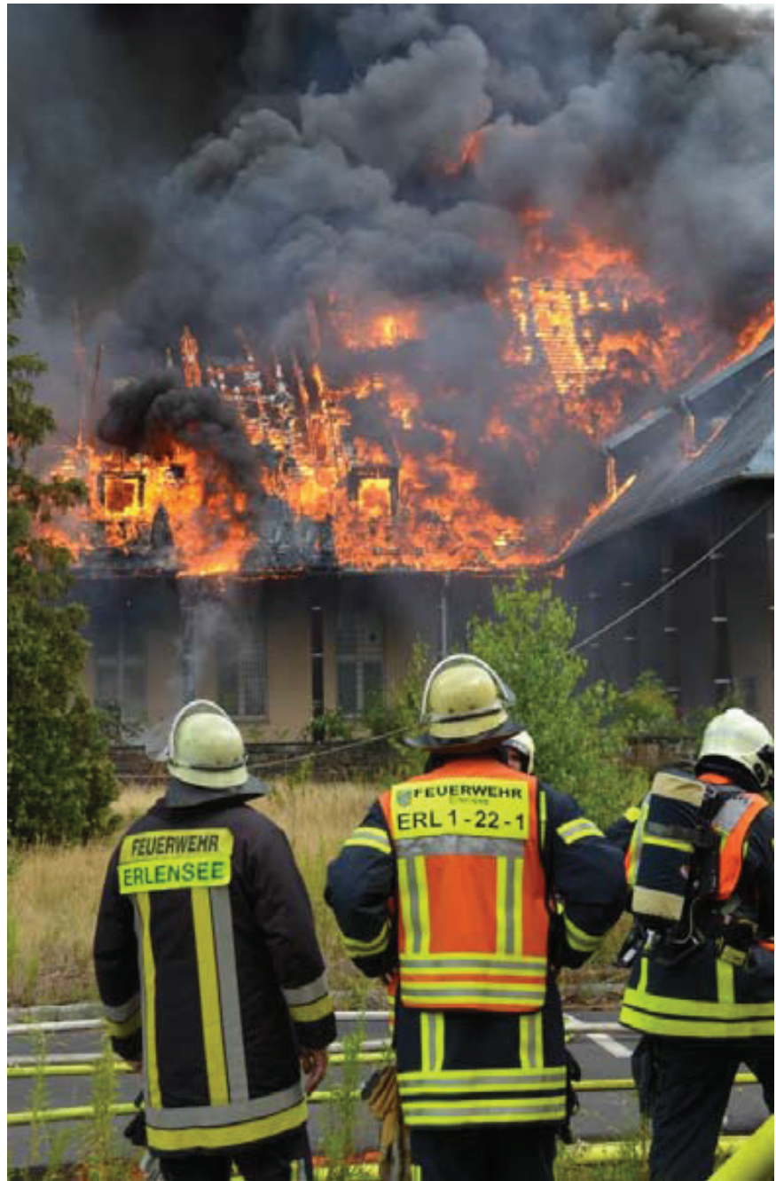
Fassungslosigkeit und Entsetzen über die Zerstörung dieses "schönste denkmalgeschützte Gebäude des Fliegerhorstes", wie oft zu hören war
