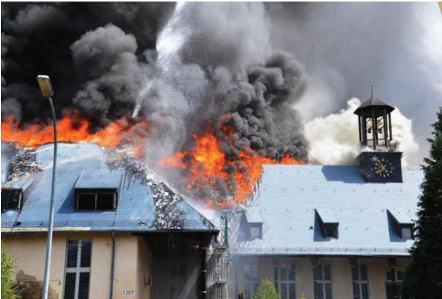
Der Brand brach im mittleren Dachstuhlbereich des Gebäudes aus
