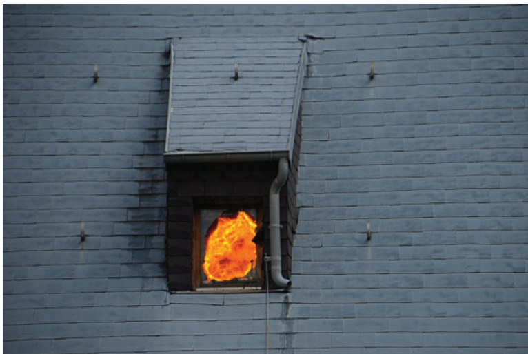
Beispiel für das Feuer im Dachstuhl. Das Dach außerhalb ist noch unbeschädigt. Dadurch gab es keine Möglichkeit das Feuer zu bekämpfen.
