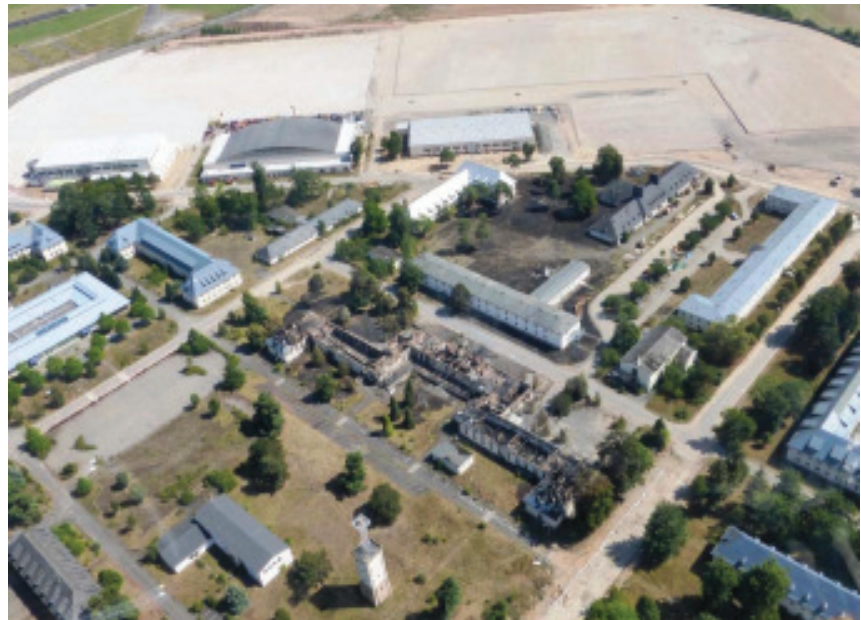
Oberhalb der Brandruine die dunkel verfärbte Fläche, die durch Funkenflug in Brand geriet
