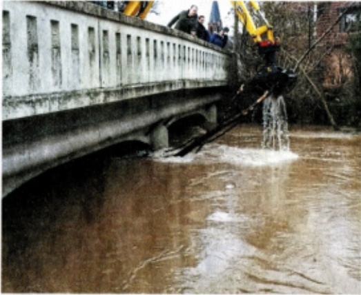
Am der Brücke iRodenbacher Straße verstopfte ein Baum den Abfluss. Ein Bagger musste eingesetzt werden. FOTO: PM
