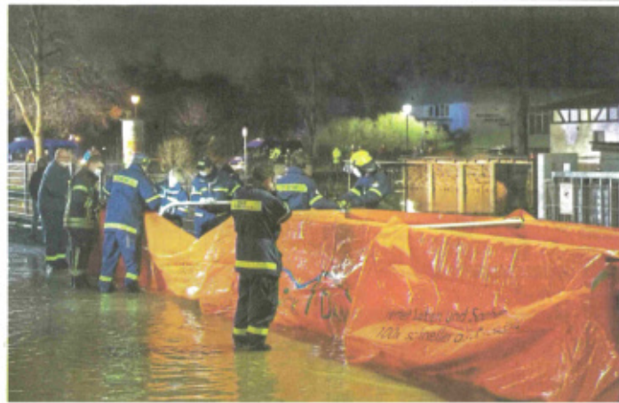
Einsatzkräfte des THW aus Erlensee errichteten in Selbold einen „Quick-Damm“.
