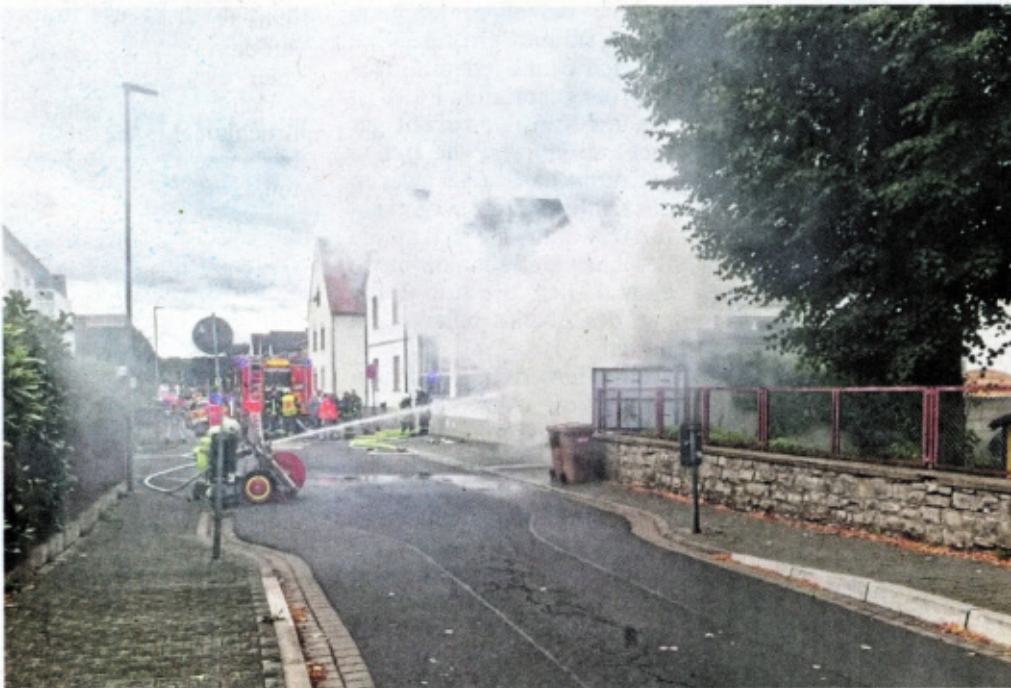
Feuer in der Trafostation: Die letzten Anlieger hatten am späten Sonntagabend wieder Strom. Nur die Straßenbeleuchtung war noch bis gestern außer Betrieb. FOTO: PM
