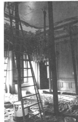
*Die durch das Löschwasser belasteten Holzbalkendecken im Museumstrakt wurden abgestützt*
