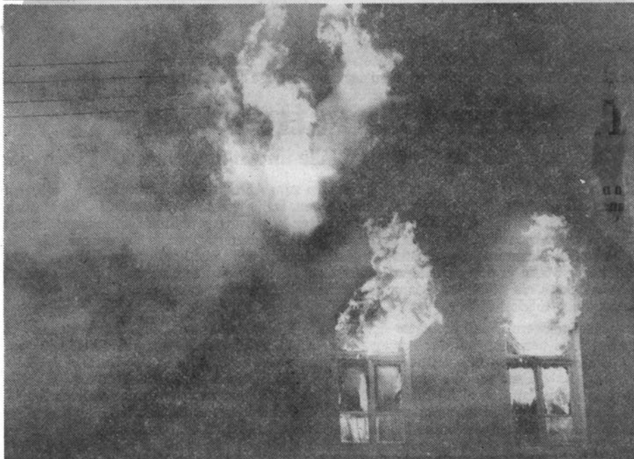
Die Fotos zeigen oben das Eintreffen der Feuerwehr und unten das Obergeschoß des zweigeschossigen Gebäudes, das innen völlig ausbrannte. Aufnahmen: Merlau
