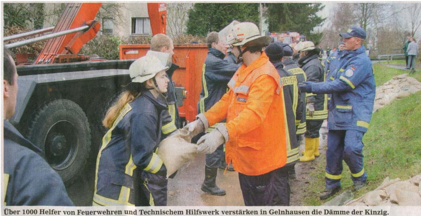
Über 1000 Helfer von Feuerwehren und Technischem Hilfswerk verstärken in Gelnhausen die Dämme der Kinzig.
