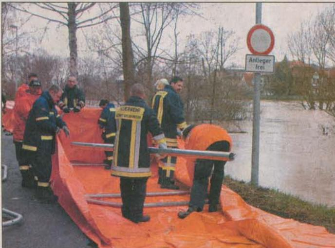
Am Ende fast 400 Meter lang: Helfer der Feuerwehr errichten am Kinzigufer einen so genannten Quickdamm aus Rohren und Kunststoff.
