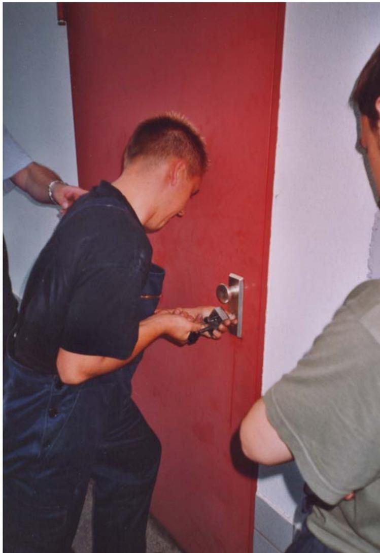
Schloß entfernen mittels Ziehfix
